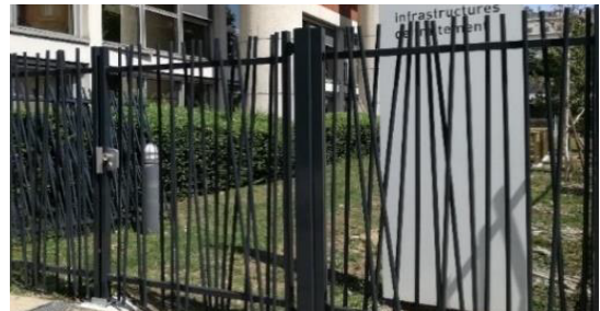
Exemples de dispositifs permettant une perméabilité de clôture pour la petite faune terrestre
